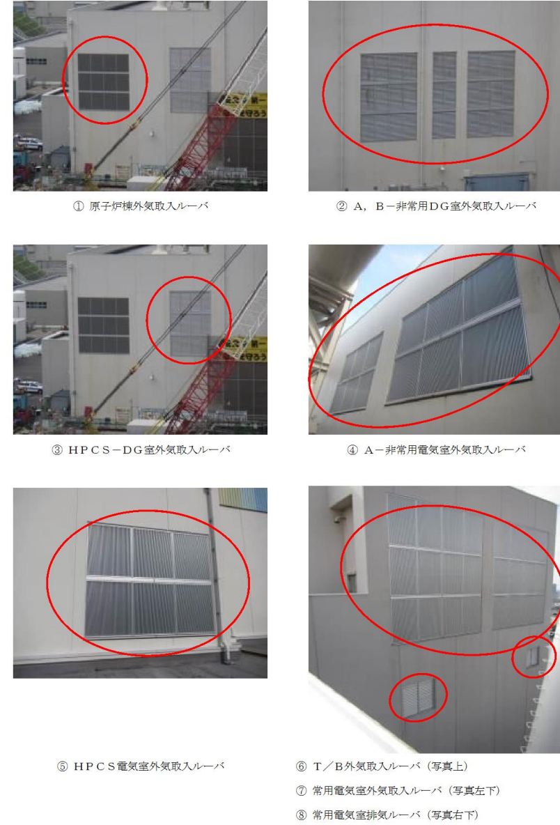
図3-1 外気取入ルーバの外観写真 (1 / 2)
