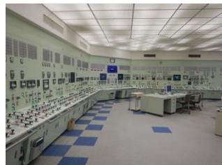
非常用交流照明点灯時 (通常時及び外部電源喪失時)
