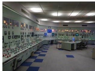
非常用直流照明点灯時
