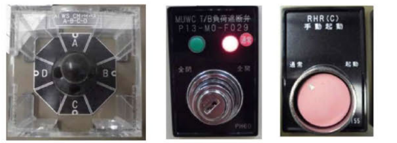
取り外し可能な保護カバー キー付スイッチ 押釦スイッチ (選択+押し込み)
