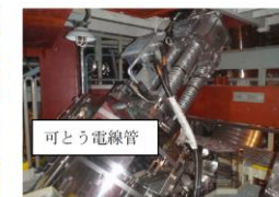
機器へのケーブル取合 (主蒸気内側隔離弁との取合)
