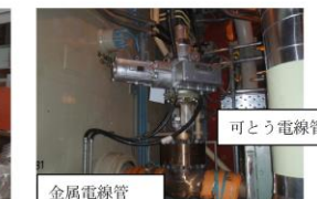
機器へのケーブル取合 (電動弁との取合)
