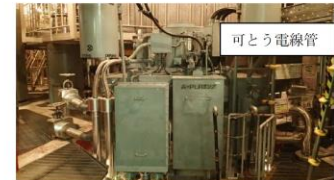
機器へのケーブル取合 (原子炉再循環ポンプ用電動機との取合)
