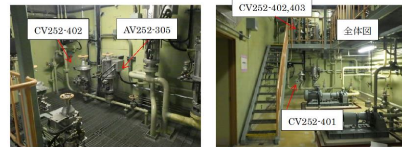
第9-11図 液体廃棄物処理系(床ドレン化学廃液系) の弁配置状況
