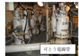
機器へのケーブル取合 (主蒸気速がし安全弁との取合)
