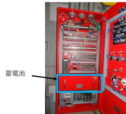
第1-28図 消火設備の電源確保の概要
