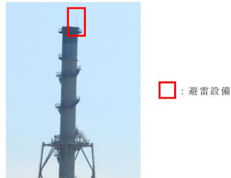
第1-16図 排気筒の避雷設備
