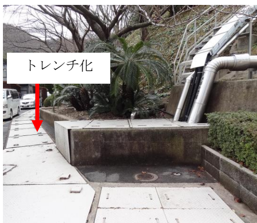
屋外消火配管のトレンチ化
