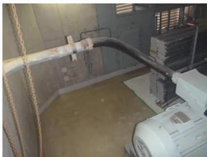
A-ディーゼル室送風機 及び可とう電線管
