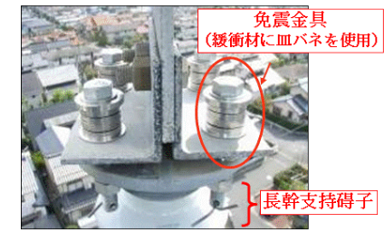
第 2.2.4-10 図 免震対策の施工状況
