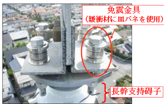
第 2. 2. 4-10 図 免震対策の施工状況
