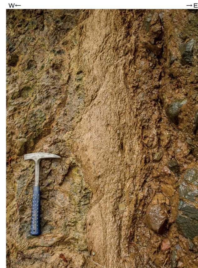
同左拡大 破碎部は幅35~45cmで、シルト質鱗片状破碎部及び細片状セピオライトからなり、軟質である。
