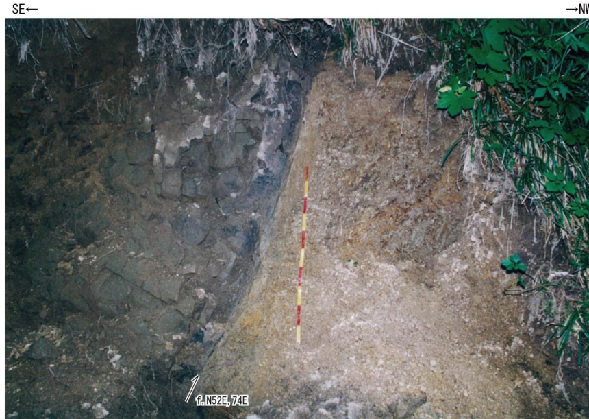
Loc. oy1 東通村小田野沢西方 東側の泊層砂岩と西側の猿ヶ森層泥岩とを境する断層。断層面沿いには幅3cm程度以下のやや軟質な粘土がみられる。
