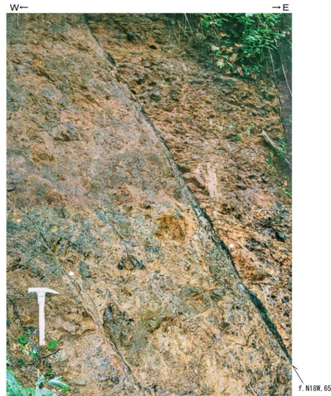
Loc. u1245 東通村老部川支流 泊層凝灰角礫岩中の断層。
