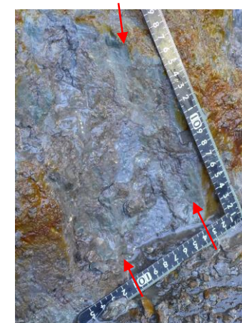
T6(2)トレンチ南面 ⑥破碎部の条線
