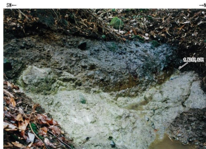
Loc. Y397 東通村小老部川支流 西側の泊層凝灰角礫岩と東側の蒲野沢層含礫砂岩とを境する断層。
