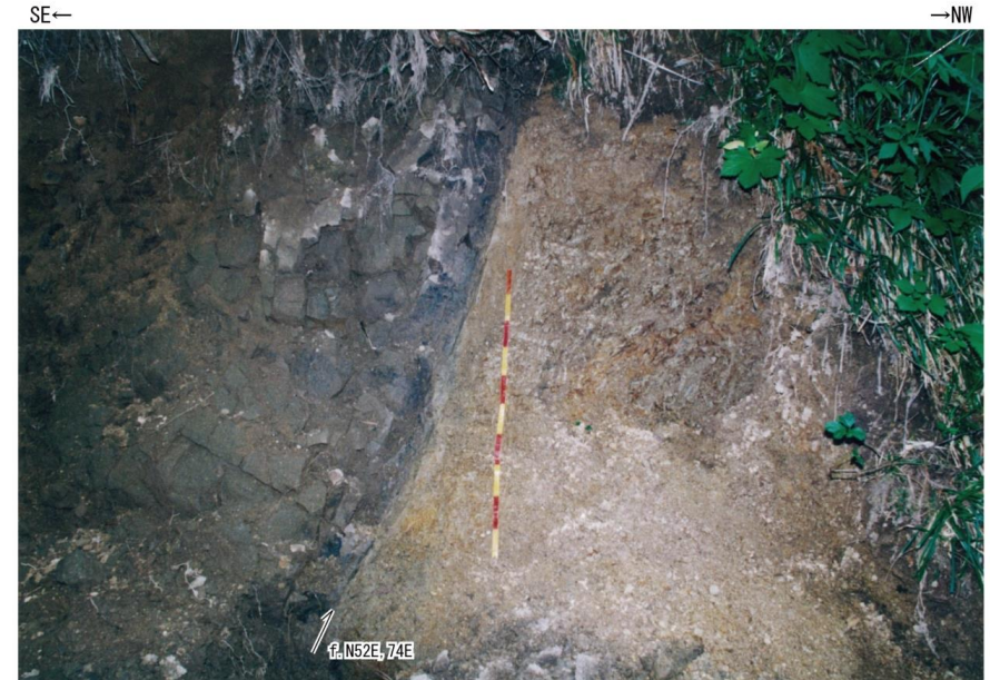
Loc. oy1 東通村小田野沢西方 東側の泊層砂岩と西側の猿ヶ森層泥岩とを境する断層。断層面沿いには幅3cm程度以下のやや軟質な粘土がみられる。
