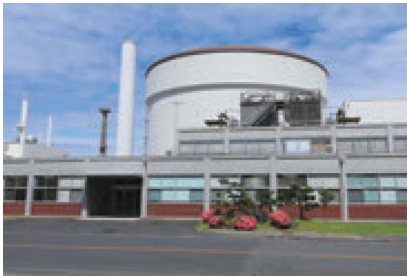
原子炉建家外観(耐震工事前)
