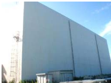
廃棄物保管棟・IIの外観
