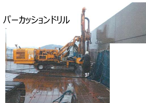
施工状況（削孔工）
