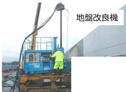
施工状況（造成工）
