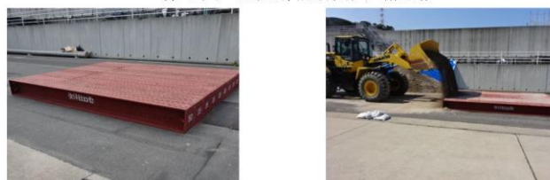
第6図 段差復旧状況
