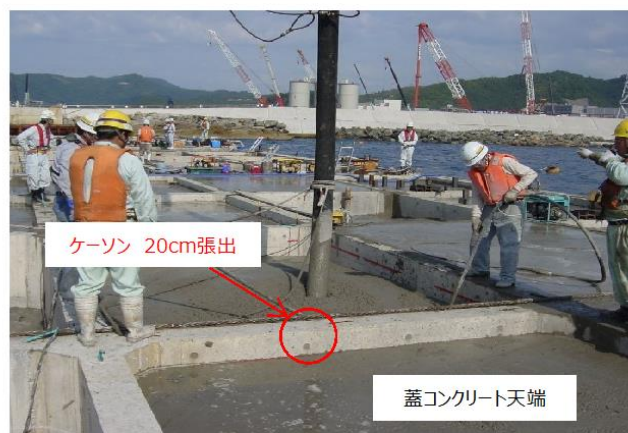
蓋コンクリート打設状況
