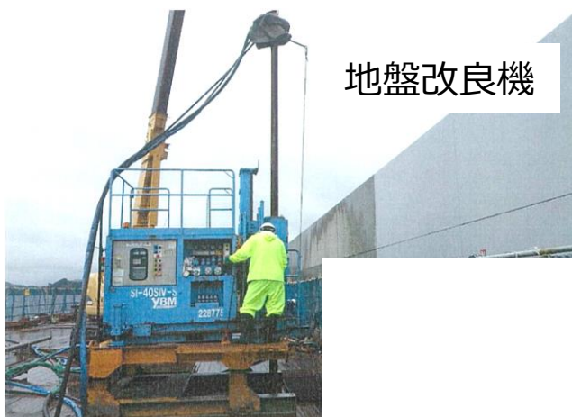
施工状況（造成工）
