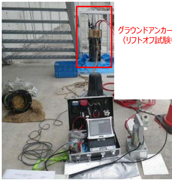
第 6-18 図 防波壁（鋼管杭式逆 T 擁壁）定期点検状況（リフトオフ試験）
