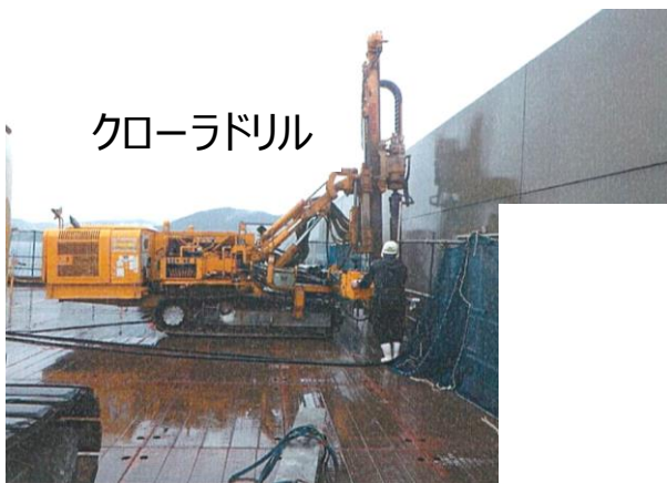
施工状況（削孔工）
