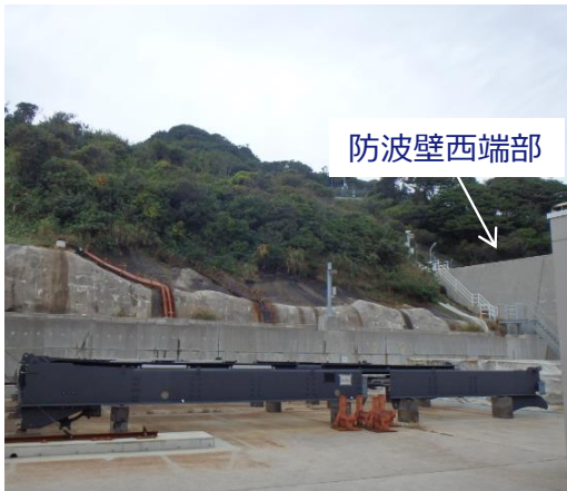
防波壁西端部 状況写真
