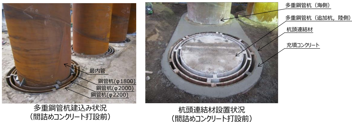
第 5-32 図 杭頭部の状況
