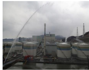
小型放水砲による放水状況
