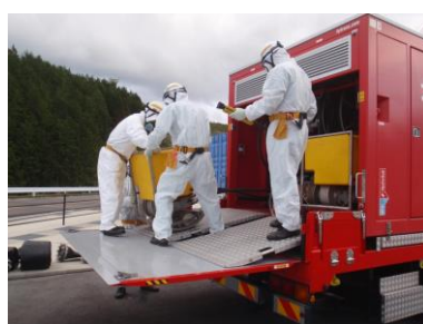
水中ポンプ設置準備
