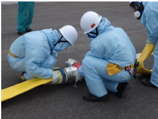
ホース接続作業（昼間）
