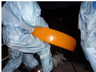
水中ポンプ設置準備（夜間）
