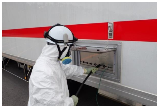
ケーブル接続作業
