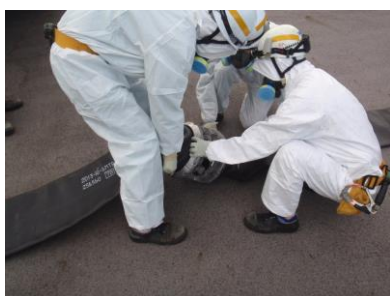
ホース接続作業
