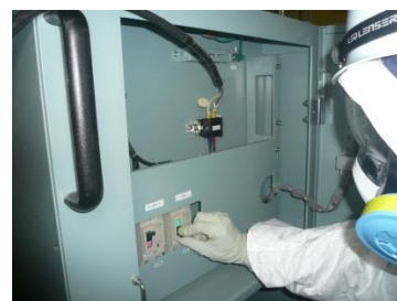
主蒸気逃がし安全弁用 蓄電池の負荷投入作業
