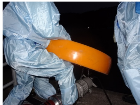
水中ポンプ設置準備（夜間）
