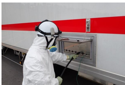
ケーブル接続作業
