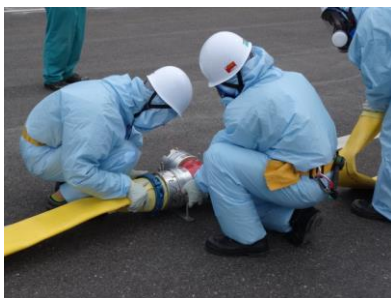
ホース接続作業（昼間）
