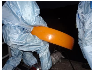
水中ポンプ設置準備（夜間）
