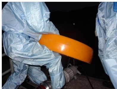
水中ポンプ設置準備（夜間）
