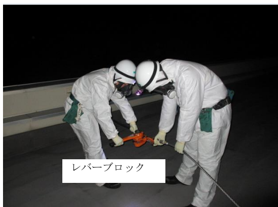
ワイヤーロープ，レバーブロック接続作業
