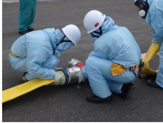
ホース接続作業（昼間）
