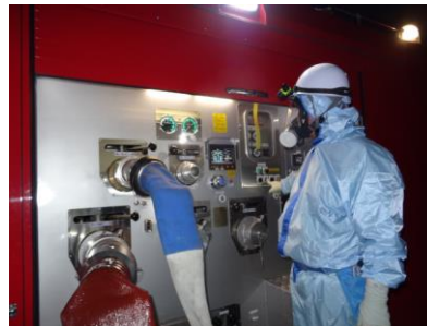
ポンプ起動操作（夜間）
