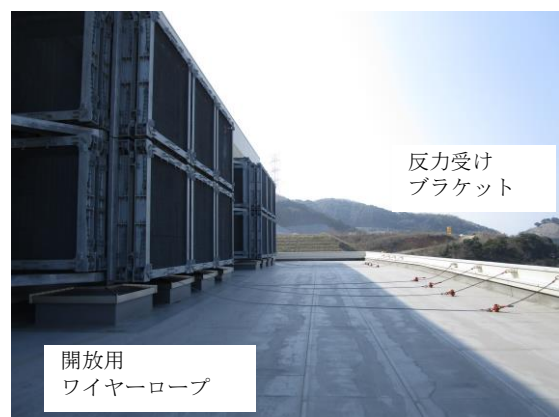
原子炉建物燃料取替階ブローアウトパネル 開放準備状態
