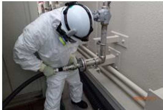
ホース接続作業
