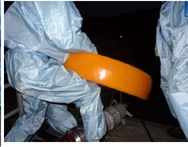
水中ポンプ設置準備（夜間）
