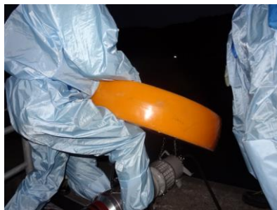
水中ポンプ設置準備（夜間）
