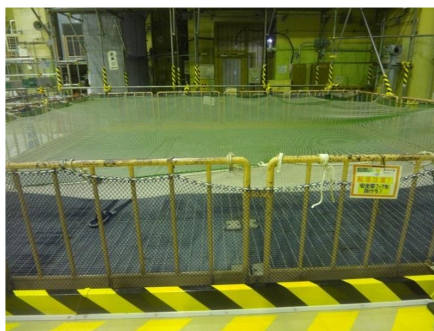
図 2 大物搬入口外観
