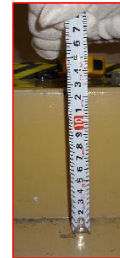
廃液処理室(IV)-1 との障壁 (高さ: 約 12.5cm) ※評価上は、保守的に 12cm とする。
