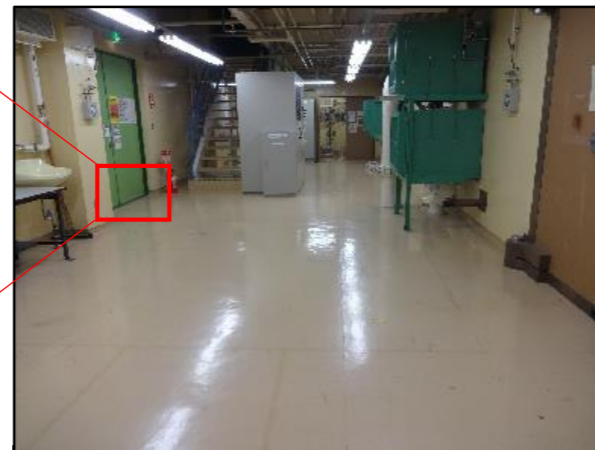
廃液処理室(IV)-1 【写真③】
