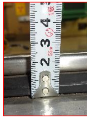
廃液処理室(IV)-1 前廊下との障壁 (高さ: 約 2.3cm) ※評価上は、保守的に 2 cm とする。
