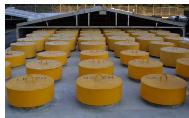
保管廃棄施設・M-2の上部の写真
