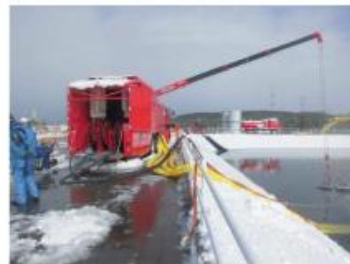
水中ポンプ設置の状況
