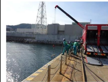
水中ポンプ設置の状況
