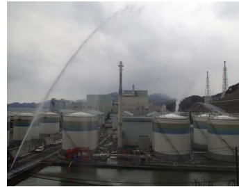
小型放水砲による放水状況
