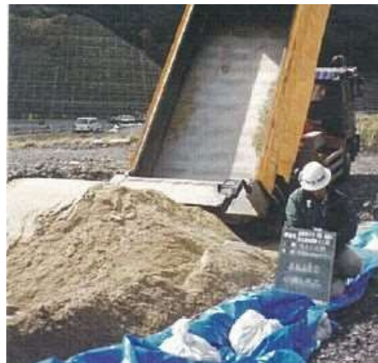
埋戻土(購入土) 現地写真(H11年)
