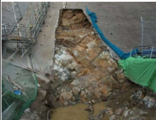
防波壁東端部 岩盤露出状況
