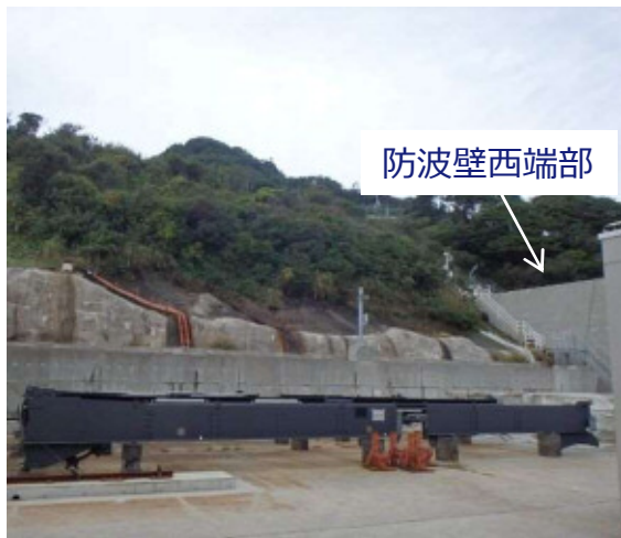
防波壁西端部 状況写真
