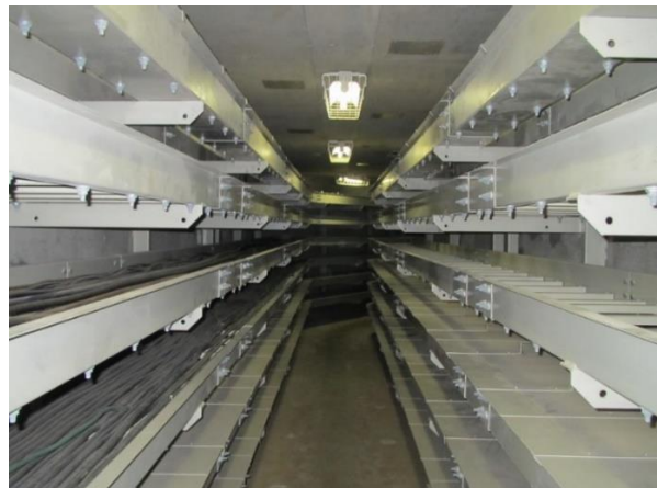
図 2. 4 ② ケーブルダクト室内
