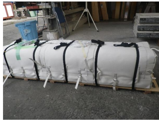
難燃シート巻設状態
