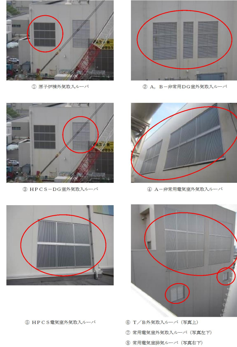
図3-1 外気取入ルーバの外観写真 (1 / 2)
