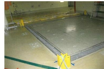
支柱レールの取付状況
