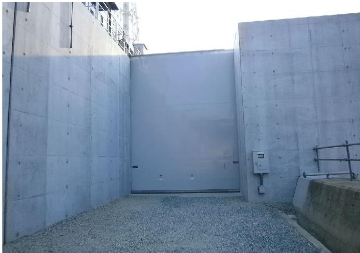
第 8-13 図 防波壁通路防波扉（1，2号炉北側）③ 設置状況
