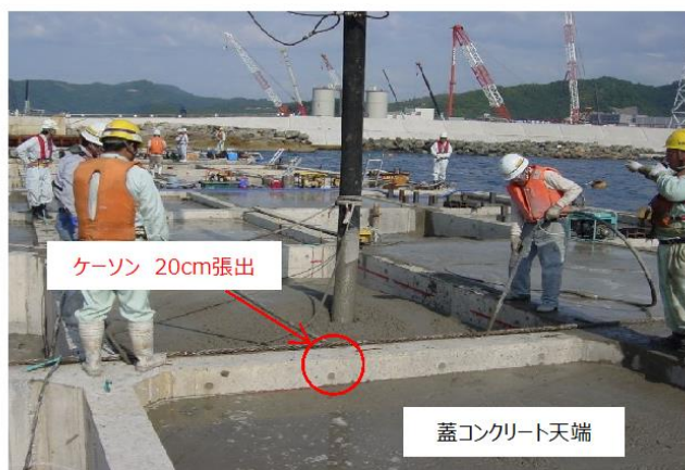
蓋コンクリート打設状況
