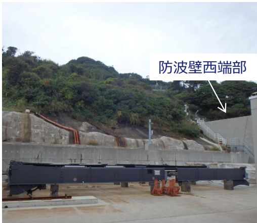
防波壁西端部 状況写真
