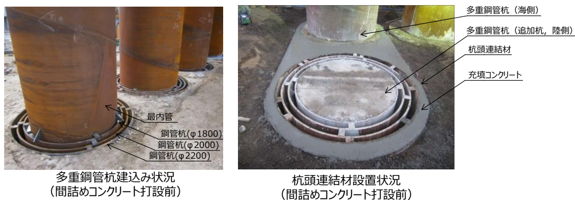
第 5-32 図 杭頭部の状況
