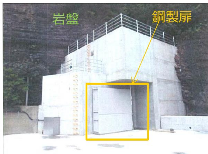
第 8-20 図 防波壁通路防波扉（1号放水連絡通路防波扉）⑤ 設置状況
