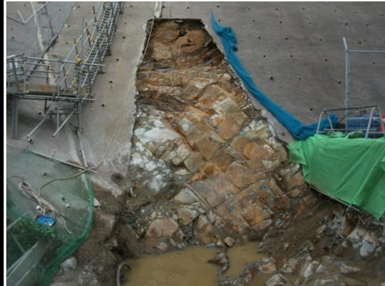
防波壁東端部 岩盤露出状況
