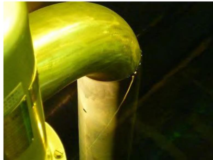
図1 サイフォンブレイク孔の設置状況
