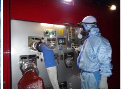
ポンプ起動操作（夜間）
