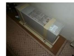
(無停電電源装置の写真)
