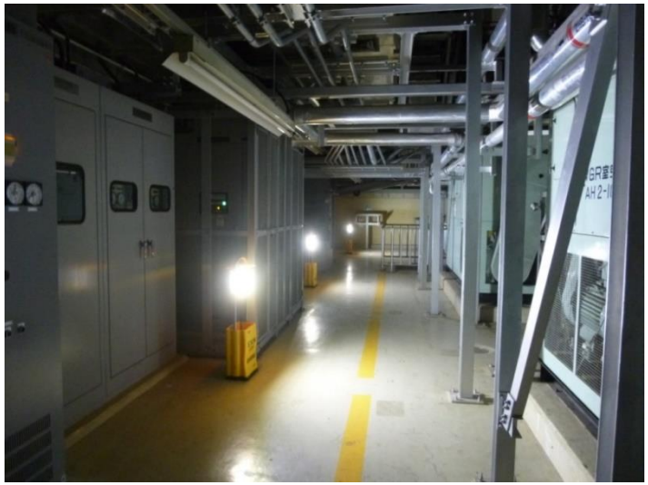
第 3.3-13 図 チェンジングエリア設置場所における可搬型照明 (SA) 確認状況
