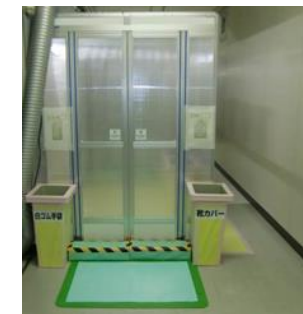
図 3.3-6 チェンジングエリアの外観
