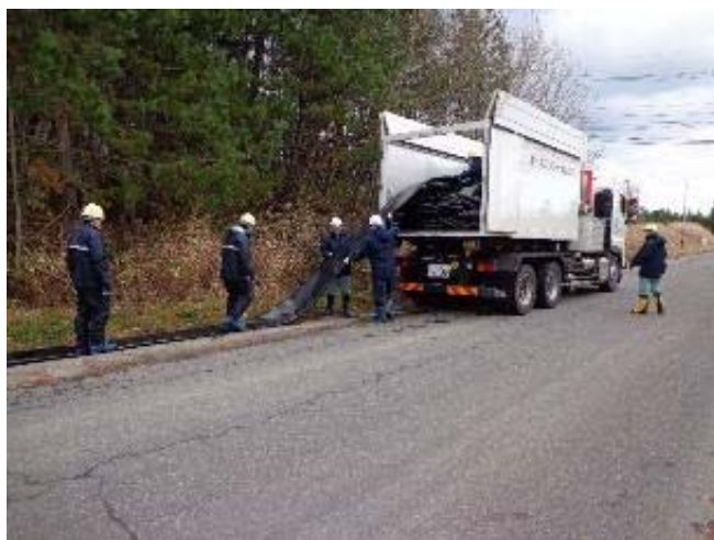
建屋外ホースの敷設
