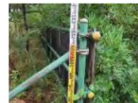
④-10 フェンス (半管柵)
