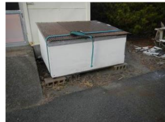
#350 鋼製ボックス
