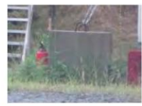
③-47 コンクリートブロック
