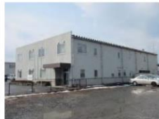
④-10 屋根, 外壁
