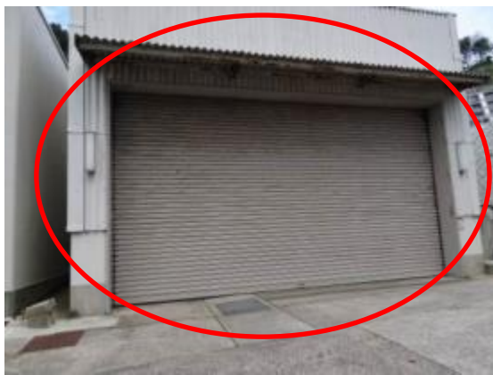
74 空コンテナ保管庫西側に面するシャッター
