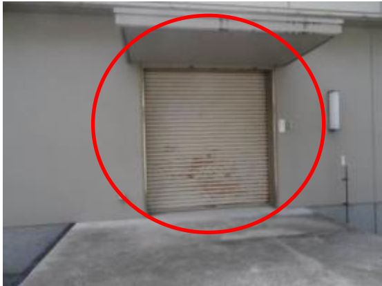
70 危険物屋内貯蔵所東側シャッター
