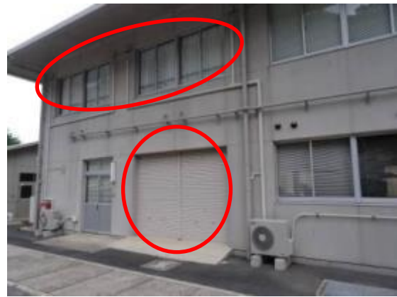
77 技術訓練棟2号館西側シャッター，ガラス窓
