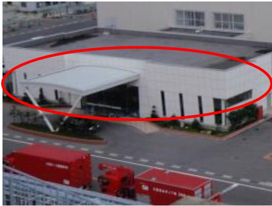
114 出入管理棟南側ガラス窓
