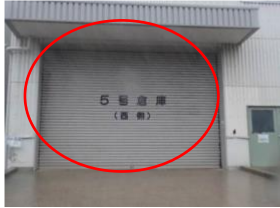
91 5号倉庫西側シャッター
