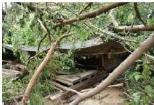
写真 3.5-18 倒木による社の倒壊
