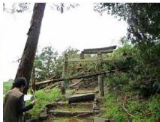
写真 3.5-16 樹木の折損と鳥居の被害
