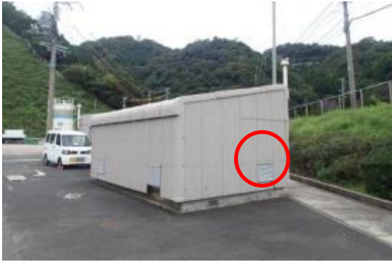
108 危険物屋内貯蔵倉庫給気用格子
