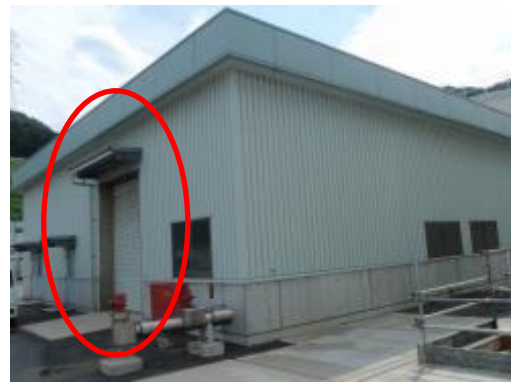
138 給水設備建物東側シャッター
