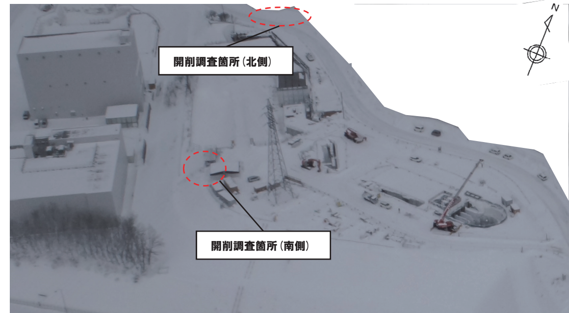
写真① 開削調査箇所(南側)付近空撮写真(H27年1月撮影)
