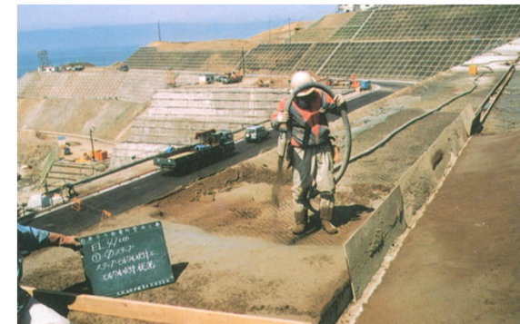
ステップモルタル工施工状況(昭和60年夏頃撮影)
