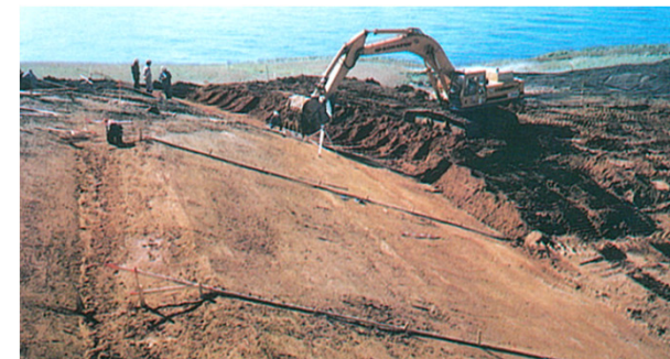
写真② 法面整形状況 (昭和58年秋頃撮影)
