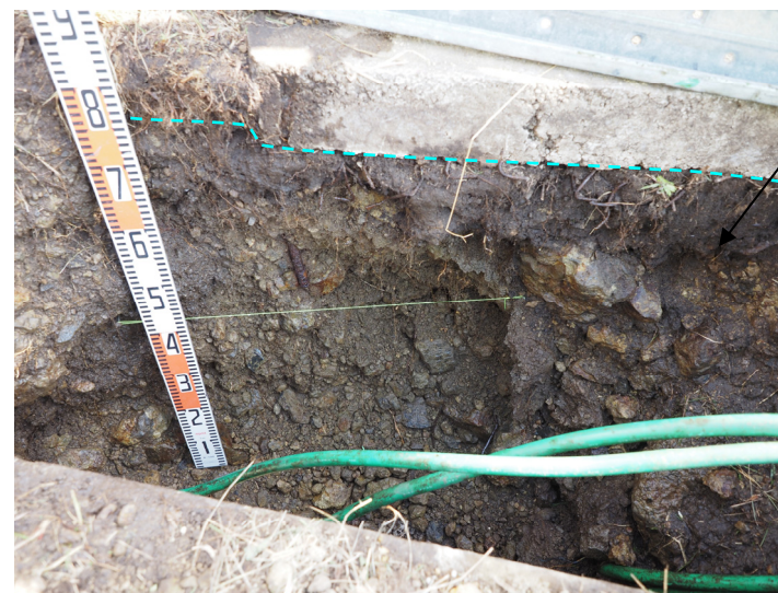
39-2地点 (南側壁面)
