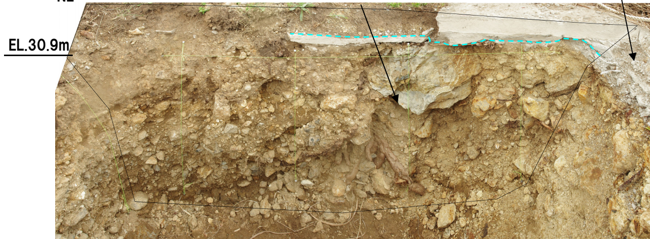
31-3地点 (南側壁面)
