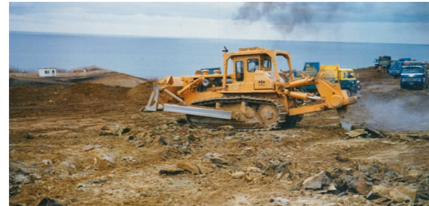
風化岩掘削 (リップピング) 状況 (昭和58年11月撮影)
