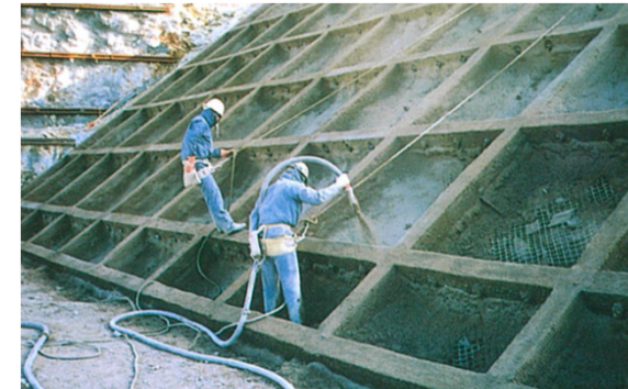
フリーフレーム工施工状況(昭和60年秋頃撮影)
