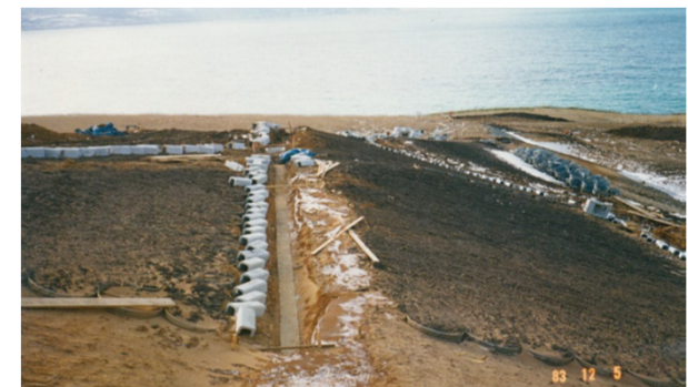
排水路工施工状況 (昭和58年12月撮影)
