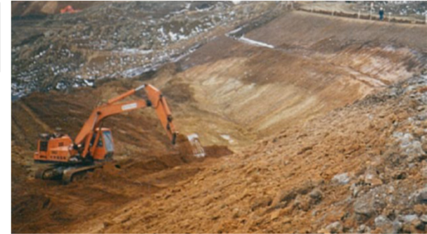
土礫掘削状況 (昭和58年12月撮影)
