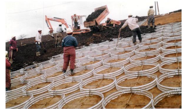
鋼製法枠工施工状況 (昭和58年秋頃撮影)
