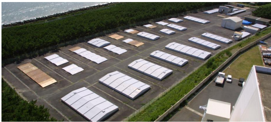
特定廃棄物の保管廃棄施設(インパイルループ用を除く)の上空からの写真
