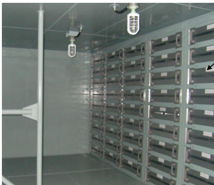
フィルタ（非常用）取付状態
