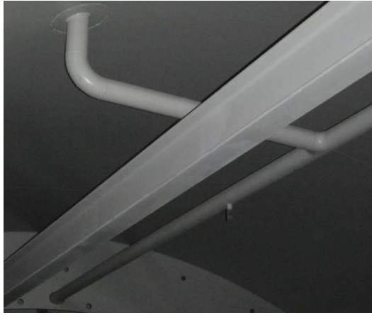
図 2.1.3-2 スprayヘッド敷設状況
