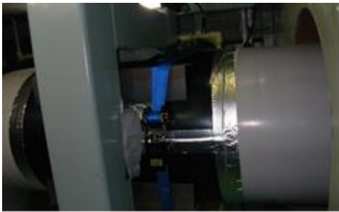
③ 修復完了
