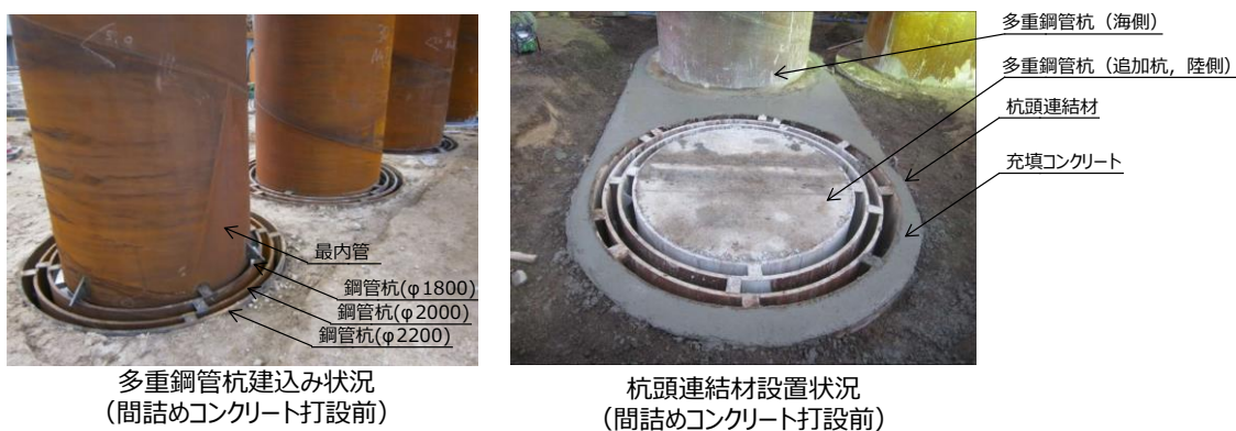
第 5-32 図 杭頭部の状況
