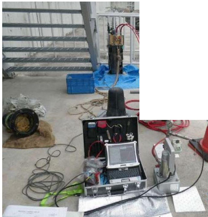
第 6-18 図 防波壁（鋼管杭式逆 T 擁壁）定期点検状況（リフトオフ試験）
