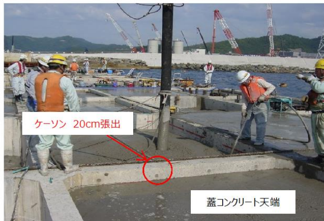
蓋コンクリート打設状況
