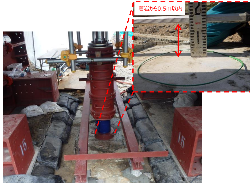
試験状況（全景）
