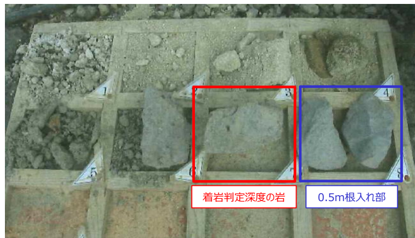
防波壁（鋼管杭式逆T擁壁）支持岩盤目視確認例
