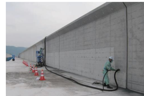
目荒らし施工状況
