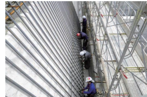
陸側鉄筋組立状況
