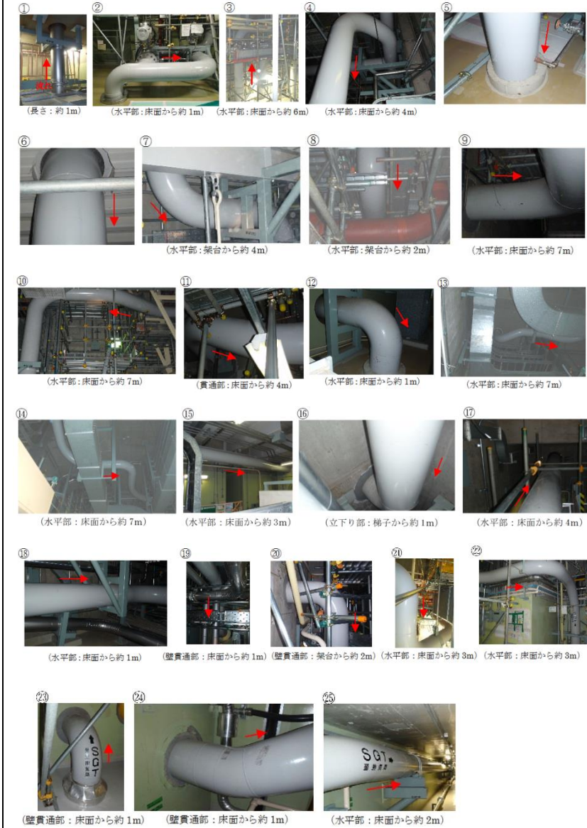
別紙図 1-9-1-2 配管敷設状況
