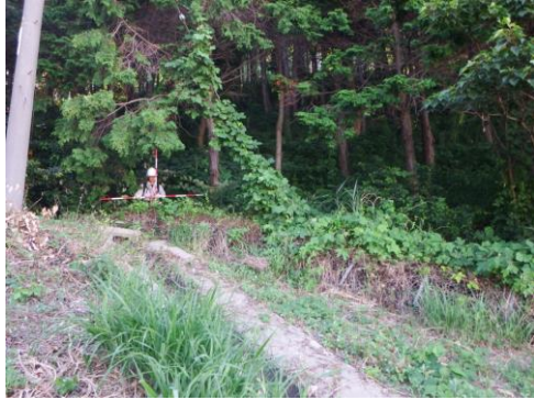
P6 谷底部中位部北端では、盛土背後の斜面が急勾配をなす。地滑り地形の側方崖に相当する可能性がある。
