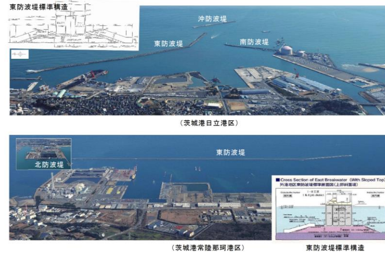
第1.2-5図 茨城港日立港区及び茨城港常陸那珂港区における防波堤整備状況 (平成28年3月)
