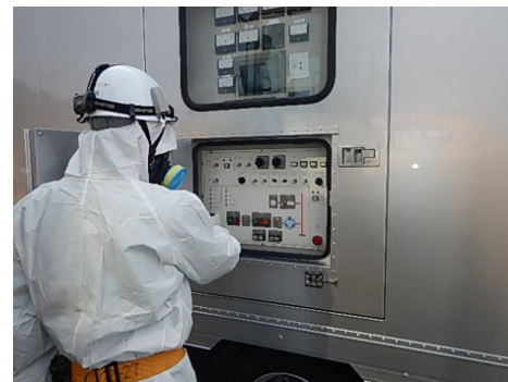
第4図 放射線防護具類を着用した状態での 高圧発電機車のケーブル敷設作業
