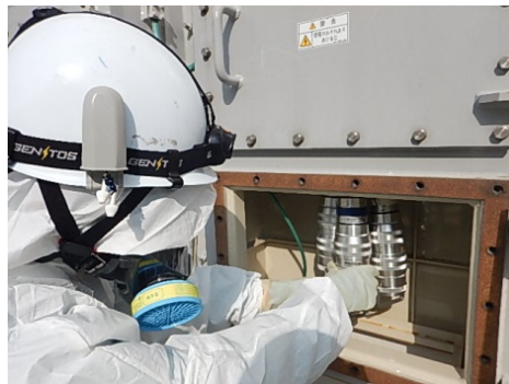
第4図 放射線防護具類を着用した状態での 高圧発電機車のケーブル敷設作業
