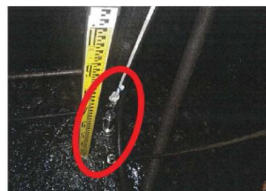
3号炉水位計の例(揚水井戸⑦)
