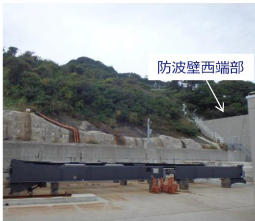
防波壁西端部 状況写真
