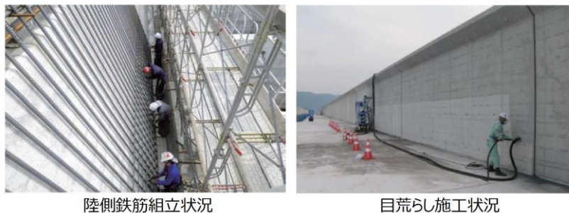
第7-37図 施工状況写真
