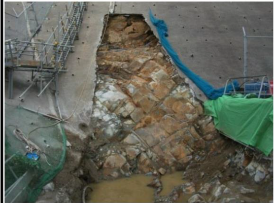
防波壁東端部 岩盤露出状況
