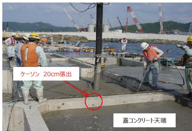
蓋コンクリート打設状況
