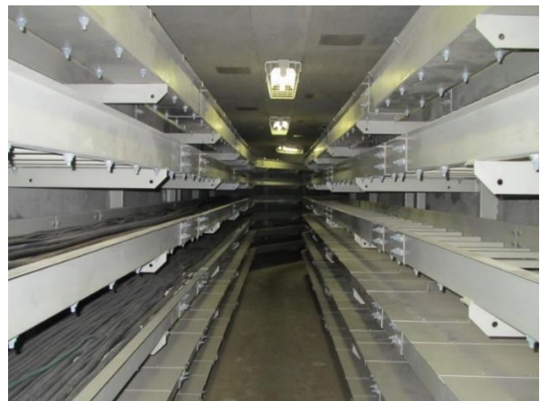
図 3. 4 ② ケーブルダクト室内
